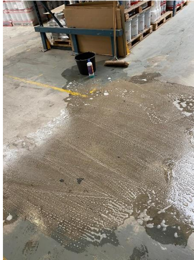
Vloer reinigen bij voorkeur met een Schrob-zuig machine met schuurnet P80 en met KP Clean
